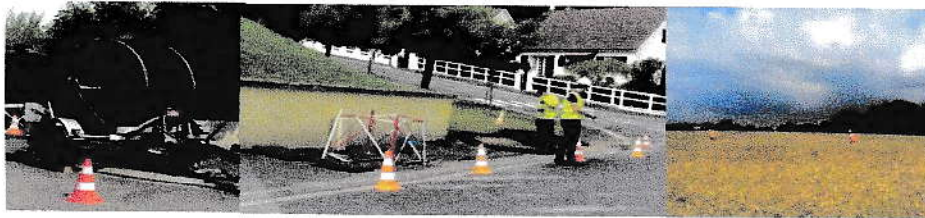
Remorque d'un touret de fibre optique et tirage de câbles
