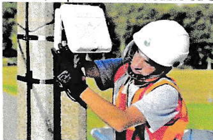
Boîtier ou point de branchement optique installé en aérien
