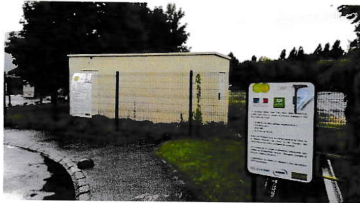
Nœud de raccordement optique
