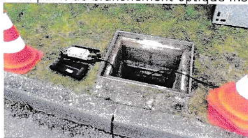
Point de branchement optique souterrain
